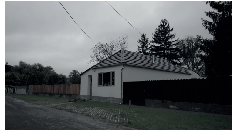
Utcai homlokzat képe a megközelítés irányából
