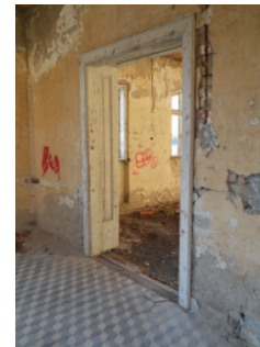
Megtartott eredeti ajtó tokszerkezet és cementlap burkolat
